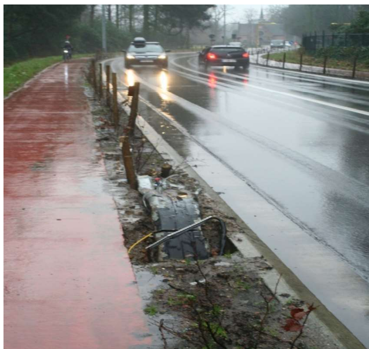
Slika 4. Pasivno bezbjedan stub pogođen sa suprotne strane vožnje funkcionisao je nezavisno o pravcu i mjestu udarca. Gornji dio stuba već je maknut. (Safety Product, Carolien Willems)
