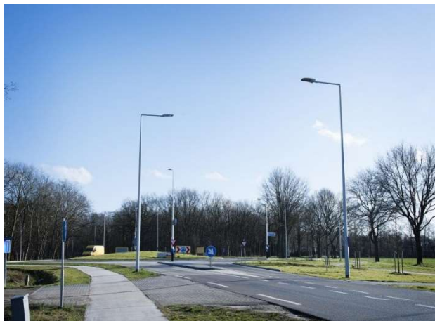
Слика 5. Кружна раскрсница и прилазни путеви опремљени пасивно безбједним stubovima јавне расvjete поштујући концепт опраштајућих путева. (Safety Product, Carolien Willems)
