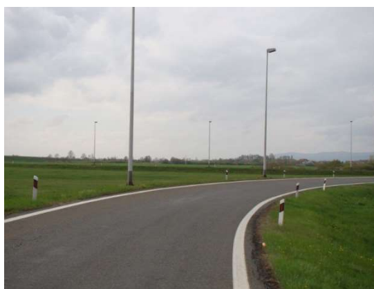
Slika 1. Izlaz sa autoputa koji bi mogao biti pasivno bezbjedan, da su bili upotrebljeni stubovi skladni sa EN-12767 tip 100HE3. Naknadno, prošle godine, zaštićeni su odbojnom ogradom.
